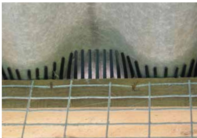
Vogelschutzmaßnahmen, Quelle: Mayringer, LK OÖ
